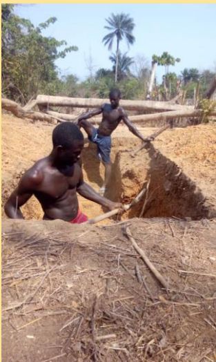
Graven van een afvoerput onder de latrines
