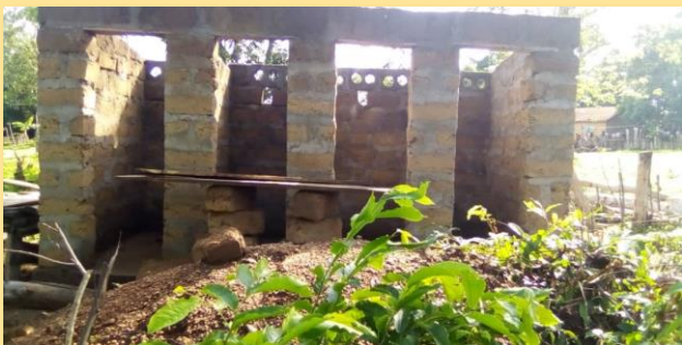
Graven van een afvoerput onder de latrines
